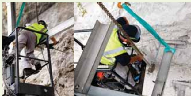
Fixation de la structure sur la paroi
