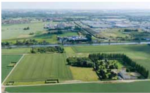
Champs captants et usine de traitement d'eau potable de Salomé
