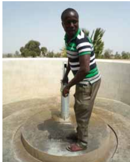
Pompe à motricité humaine sur un forage bétonné et protégé pour une bonne hygiène
