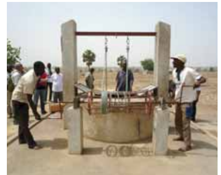
Détail de l'équipement Treuil et volets de fermeture
