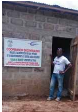
Le bâtiment des latrines du centre Agro-écologique Tsiviépé au Togo
