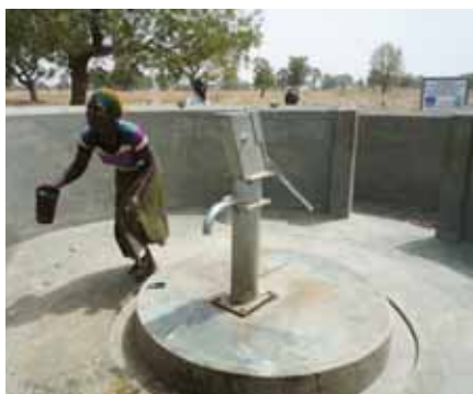
Détail de l'aménagement d'un forage la chicane organisée à l'entrée interdit l'accès aux gros animaux
