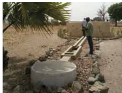
Vue extérieure d'un aménagement de forage Un canal de récupération des eaux permet d'éviter de détremper le sol autour du forage et de créer un abreuvoir pour les animaux
